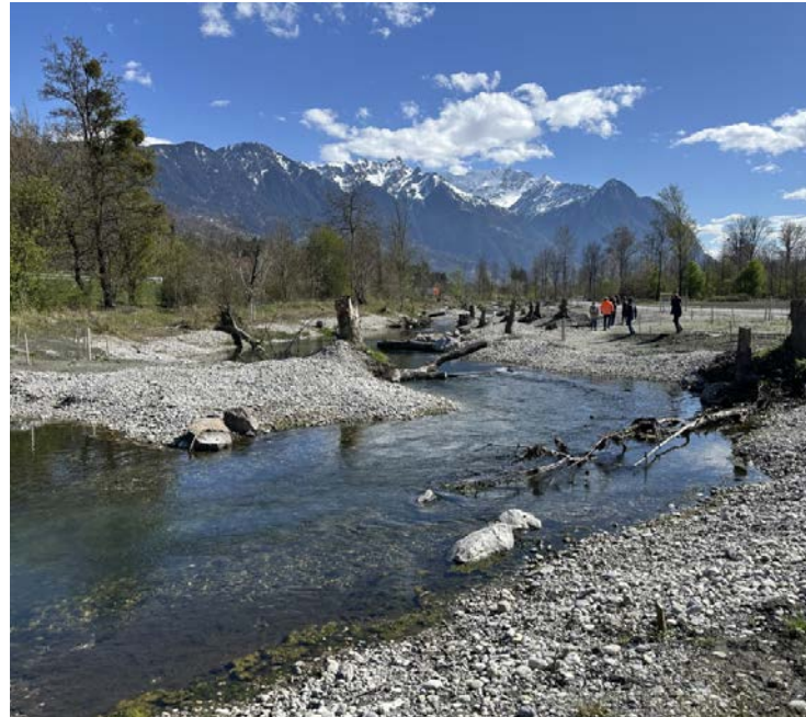
Durch den Einsatz natürlicher Baumaterialien wie Holz und Steine werden neue Strukturen im Kanal geschaffen, welche Lebensraum für Fischarten wie die Bachforelle bieten und die Biodiversität insgesamt fördern. (Bilder: WBK)
